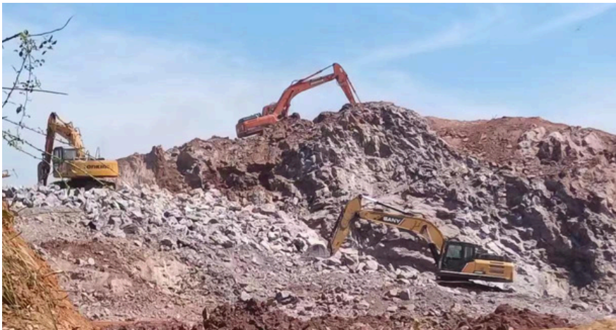
7月24日上午，征拆部、兴港公司会同测绘院现场处理施工边线纠纷问题。
