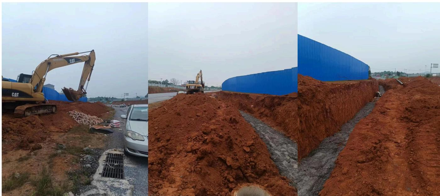
6月3日上午，铁路供电线迁改现场正在开展通道覆土、砌筑检查井的工作。
